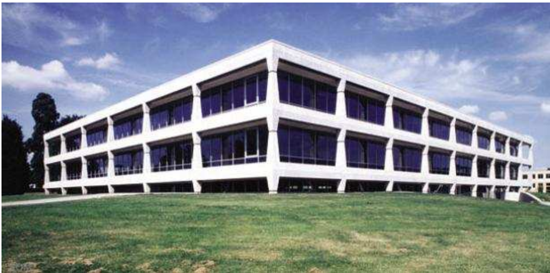
Figura 6 – Centro de Investigação Skidmore Owing & Merrill Heinz
