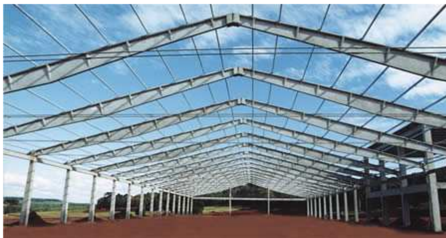
Figura 26 – Vigas tesoura utilizadas em sistema aporticado
