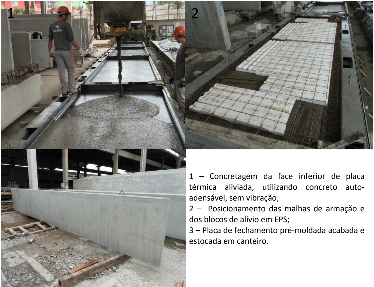
Figura 18 – Processo de fabricação de painéis para vedações
