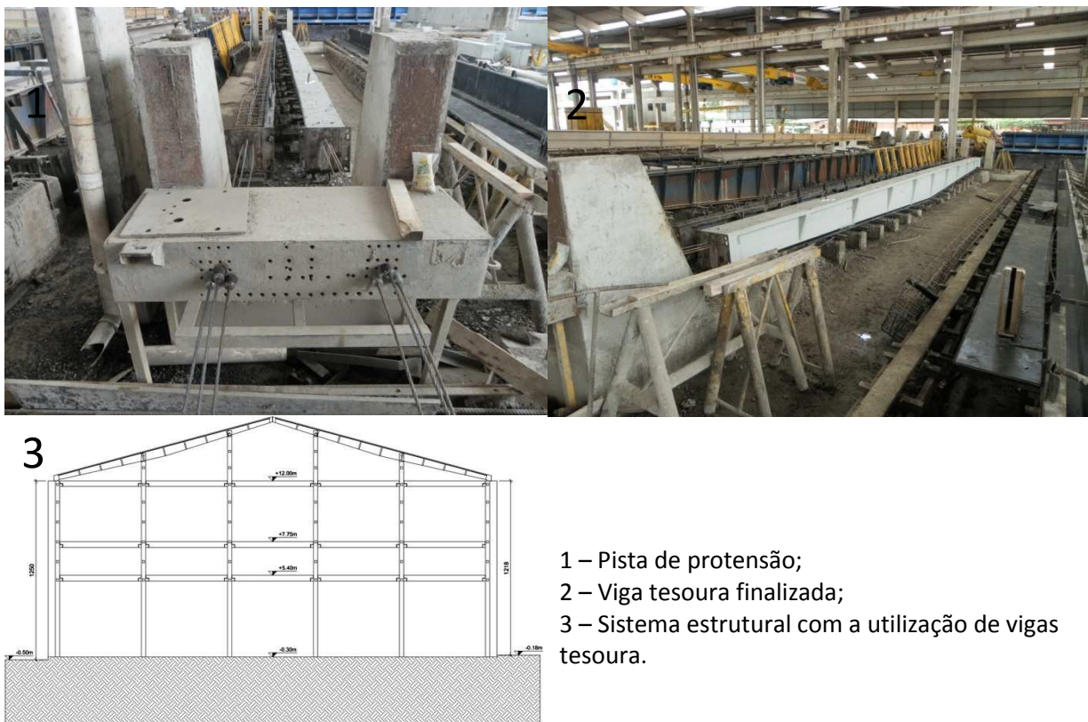
ELEVAÇÃO LATERAL DIREITA Figura 20 – Processo de moldagem e utilização de viga tesoura protendida
