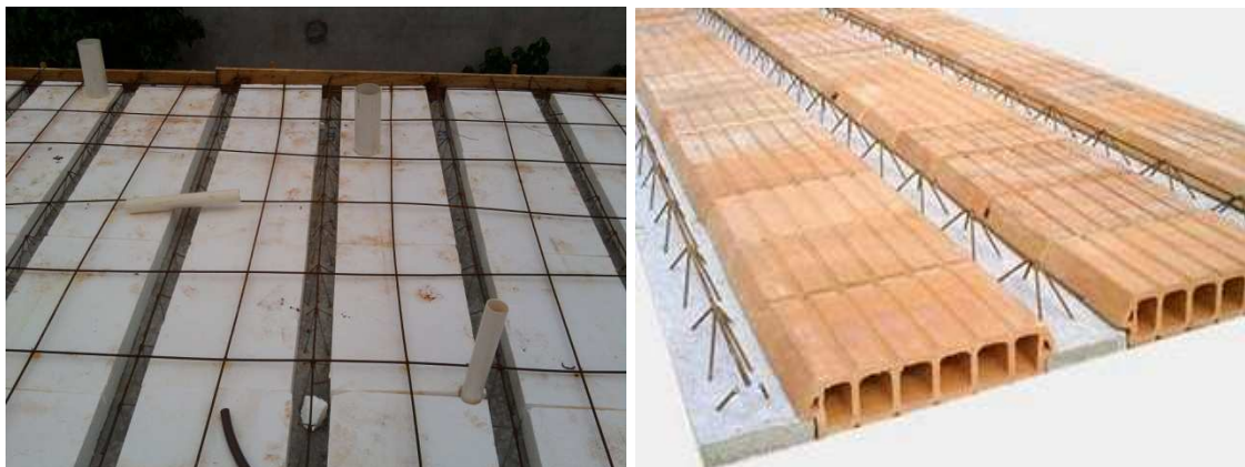
Figura 36 - Lajes treliçadas com elementos de enchimento em EPS e blocos cerâmicos
