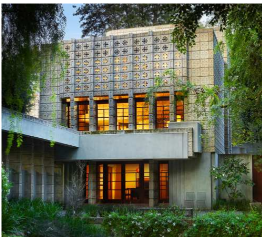
Figura 2 – Detalhe dos blocos vazados texturizados
