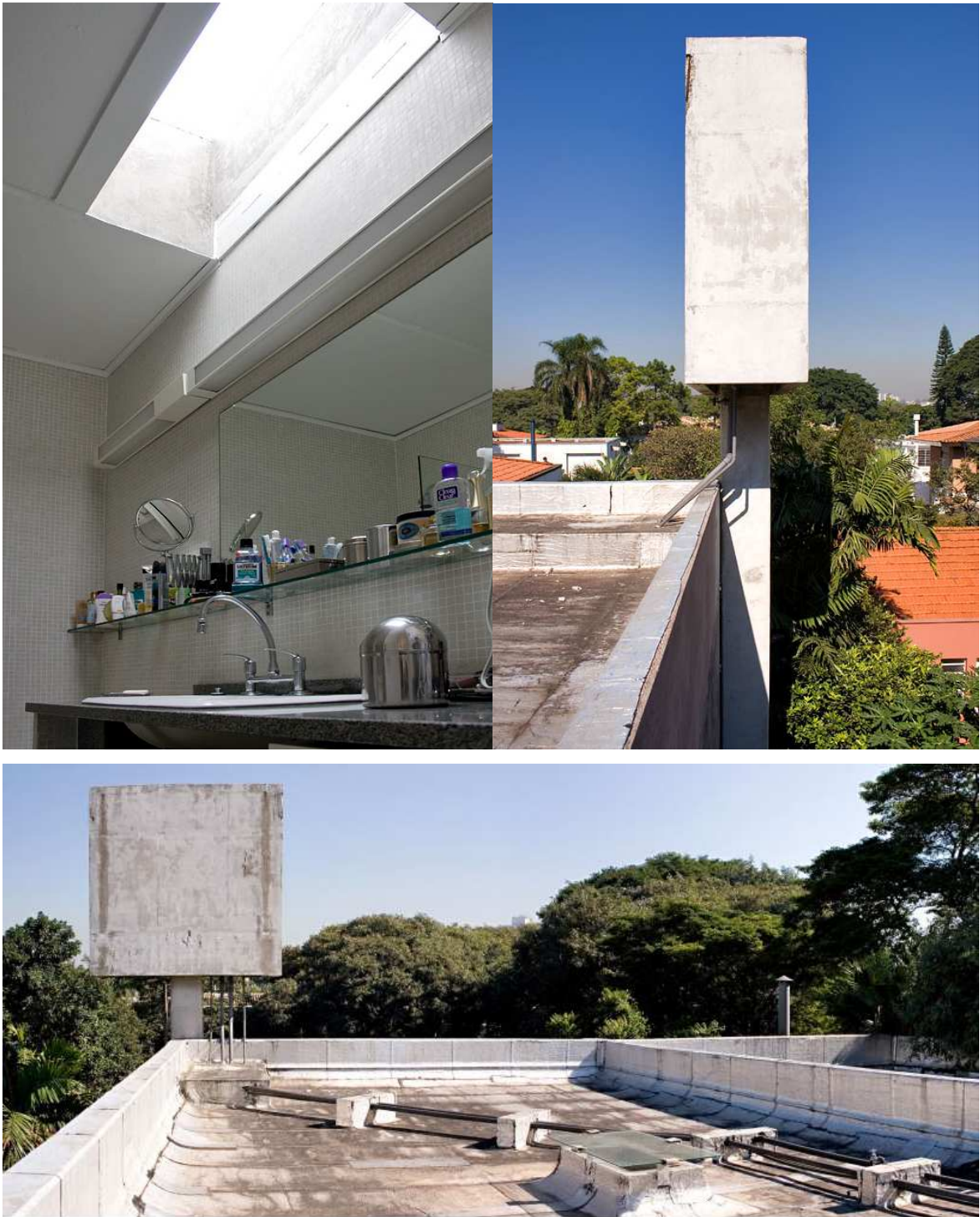
Figura 57 – Detalhe de iluminação na cozinha e caixa d'água apoiada em pilar
