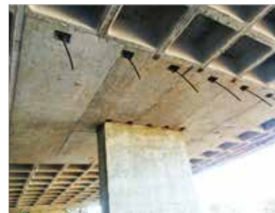
► Figura 4 Detalhe da “protensão chapéu” realizada nas regiões maciças
