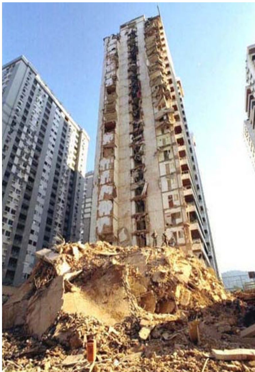
Figura 4 – Visão do Edifício Palace II, Brasil, após o desabamento em 1998 (fonte: http://www.palace2.org.br/desaba05.html )
