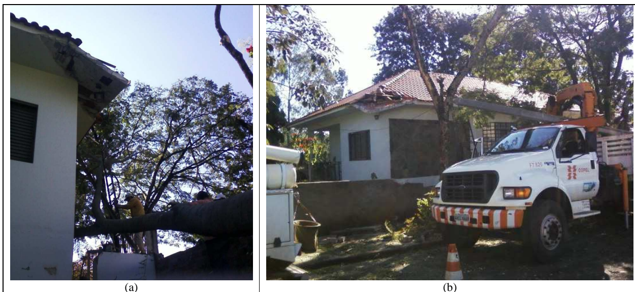
Figura 1. (a) Ruína de beiral em residencial devido ao corte inadequado de uma árvore (b) Instalação de novo poste para reativação da rede elétrica na região do sinistro
